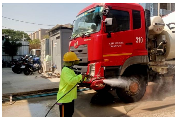
รูปที่ 37 ล้างล้อรถบรรทุก
