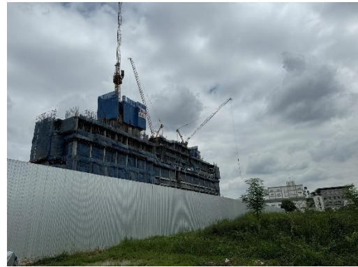
รูปที่ 1 รั้วทึบชั่วคราว (Metal Sheet) รอบพื้นที่โครงการ
