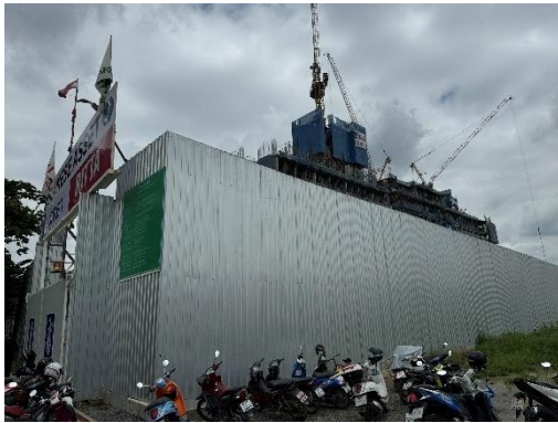
รูปที่ 1 รั้วทึบชั่วคราว (Metal Sheet) รอบพื้นที่โครงการ
