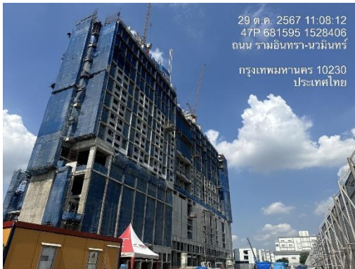
รูปที่ 7 ผ้าใบก่อสร้างกันฝุ่น Mesh Sheet
